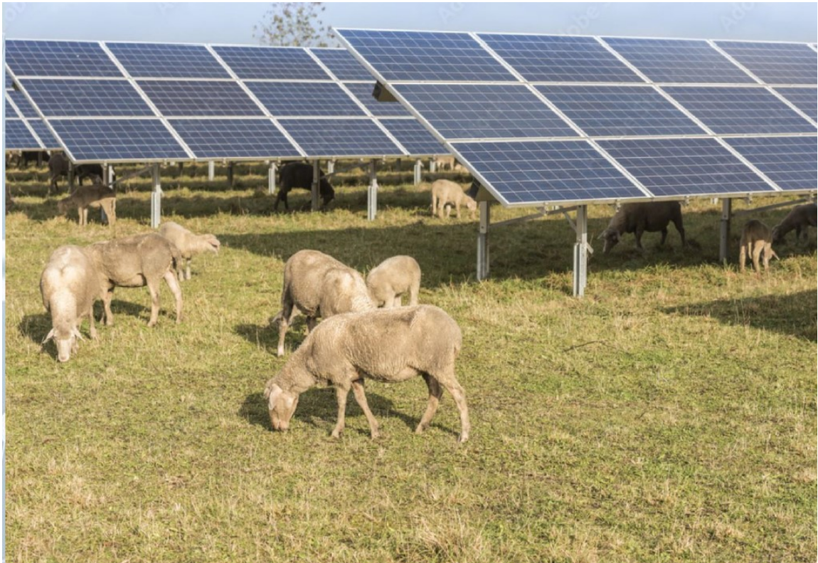
Abbildung: Beispielbild zur Veranschaulichung des Vorhabens (Quelle: Waldsichtenergie GbR, Uedem)
