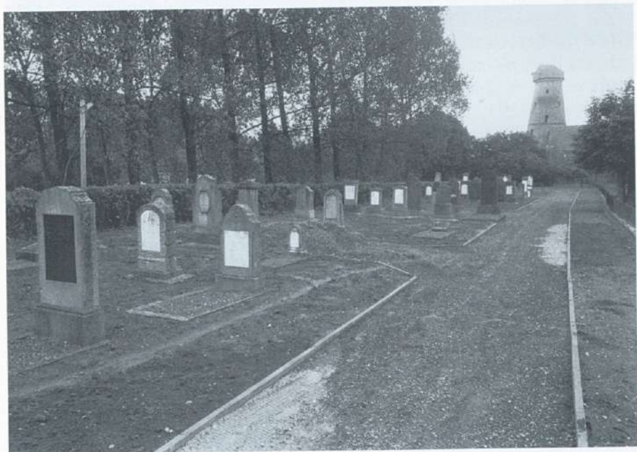
Umgestaltungsarbeiten im September 1987 (Foto: Andreas Hemstege)
