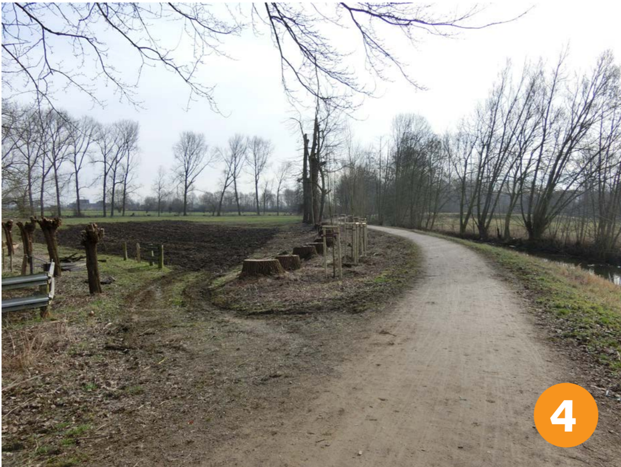
Fußwege in Dammlage südlich der Hanselaerstraße
