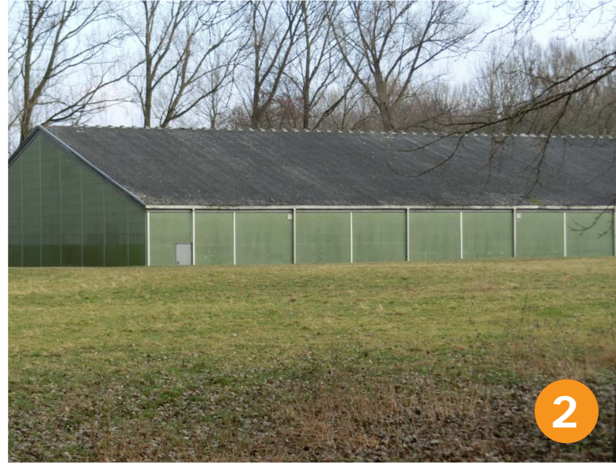
Gestalterisch nicht integrierte Tennishalle
