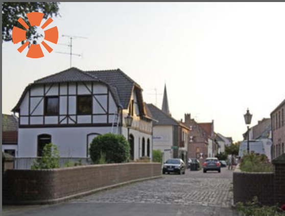
Überbrückung durch Straße
