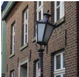
Einige Leuchtenköpfe befinden sich in auffälligem Zustand.
