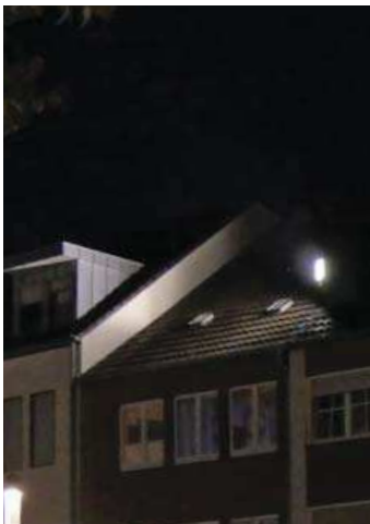
Dachmontierte Strahler zur Anstrahlung der Rathausfassade
