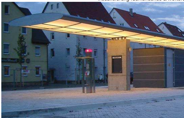
Assoziationsbild beleuchtete Überdachung Bushalt
