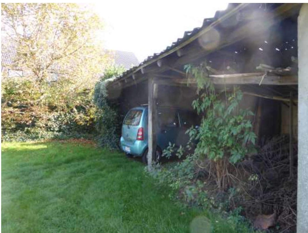
Foto 4: Blick auf den PKW-Unterstand mit offener Bauweise
