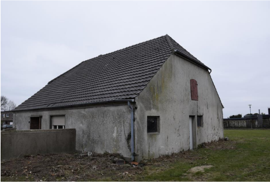
Außenansicht des Wohngebäudes
