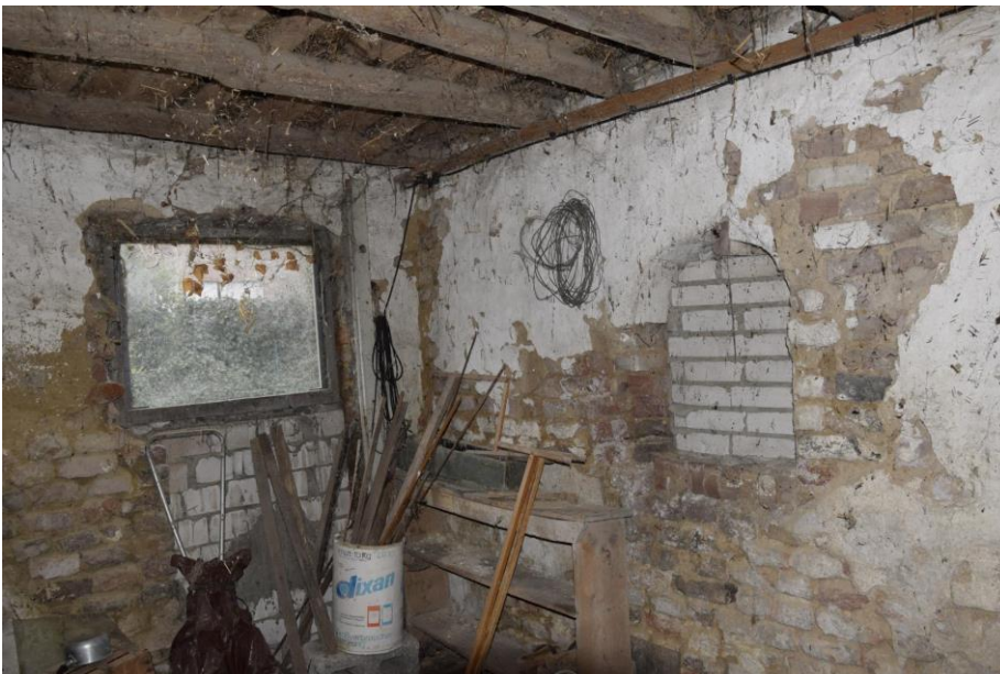
Stalltrakt, am Wohnhaus angeschlossen
