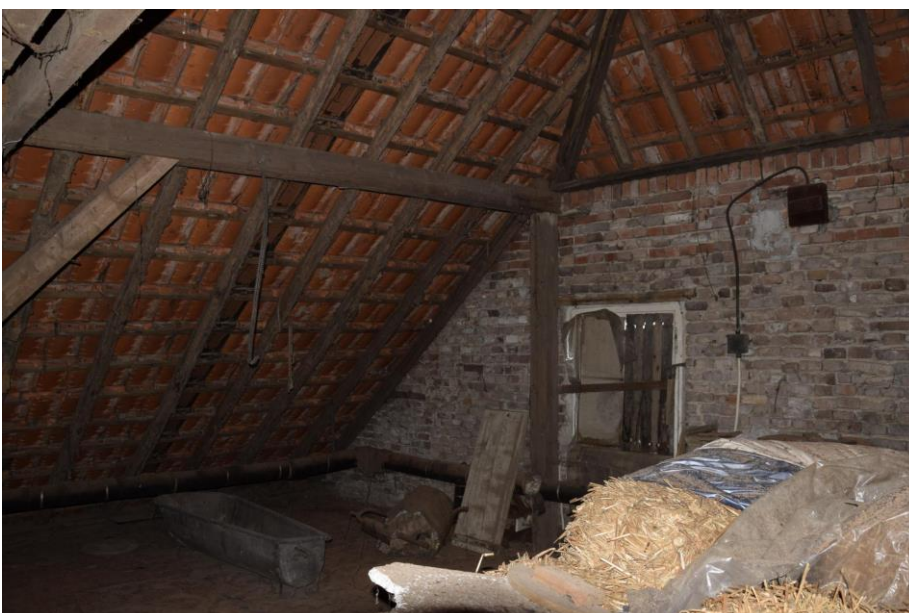
Dachboden des Wohngebäudes
