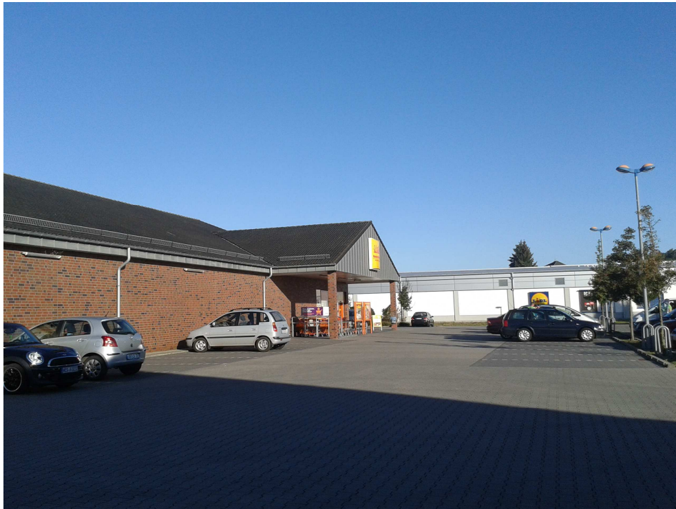
Foto 3: Blick von Südosten auf den Parkplatz und den Netto-Markt
