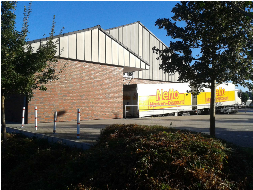
Foto 2: Blick von Süden auf den Netto-Markt
