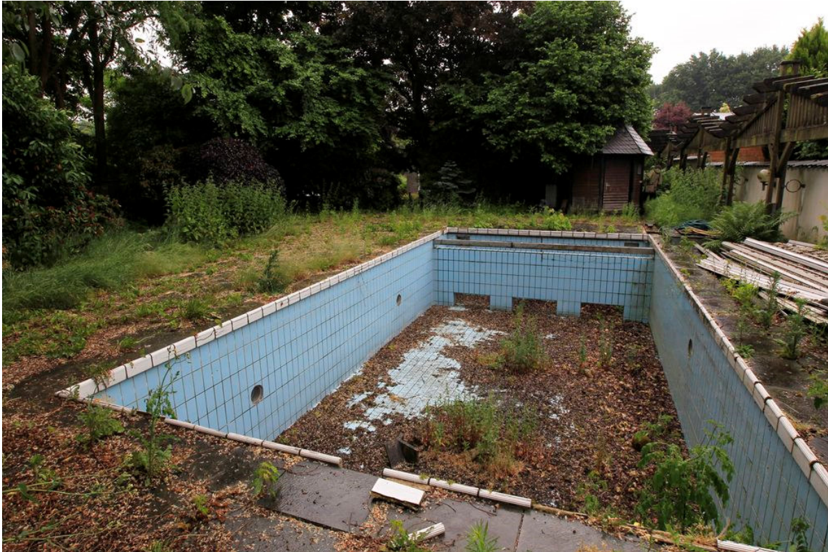
Foto 3: Der geplante Neubau wird teilweise im Bereich des jetzigen Schwimmbeckens errichtet. Hinter dem Becken befindet sich der unterirdische Wartungsraum. Die Bäume im Hintergrund sollen weitgehend erhalten bleiben (Sudmann, 06.06.2017).
