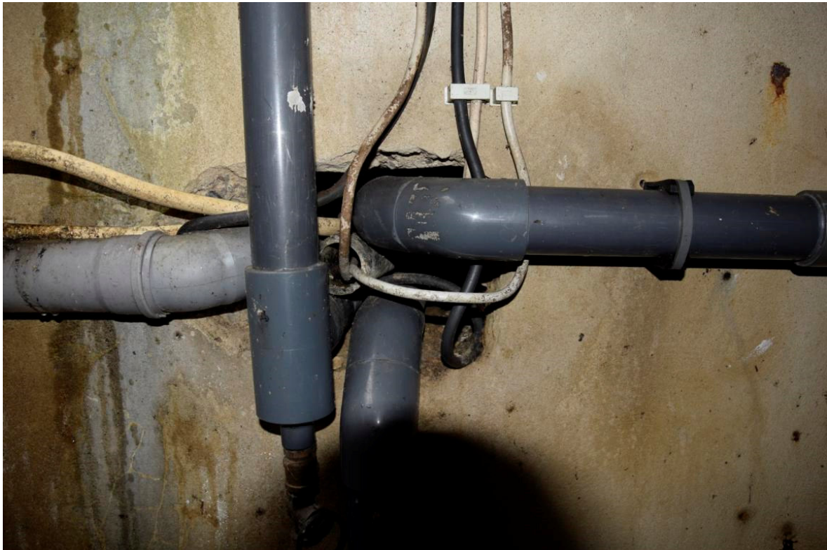
Foto 5: Untersucher Rohrschacht im Wartungsraum des Schwimmbeckens (Steinhäuser, 06.06.2017).
